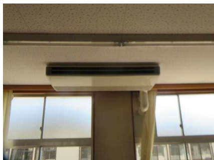
大きなエアコンが設置されました
