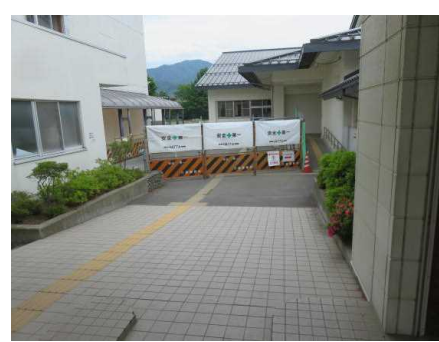
外トイレの解体・改修始まりました
